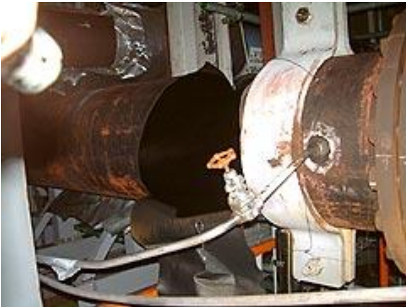
原子力発電所の配管
